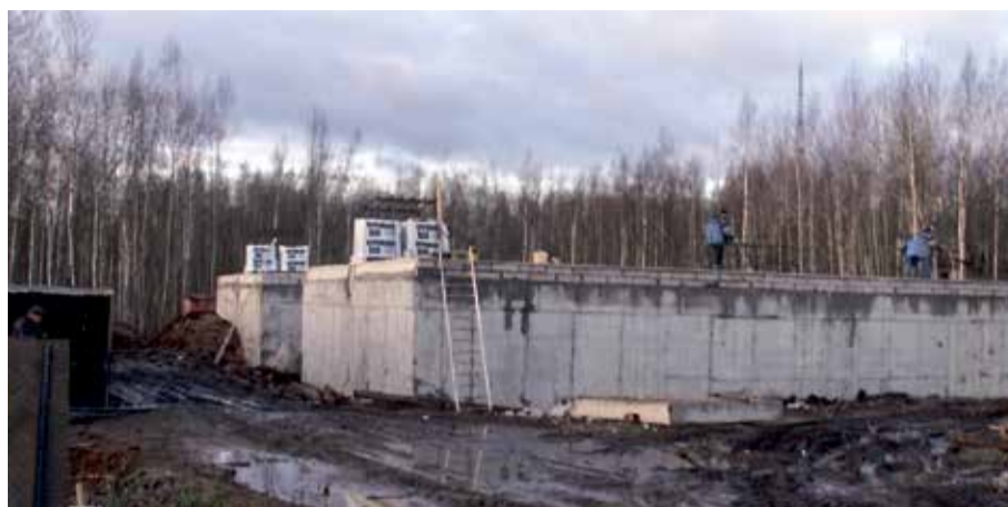
Строительство резервуаров для хранения воды (зд. 699/1,2)
